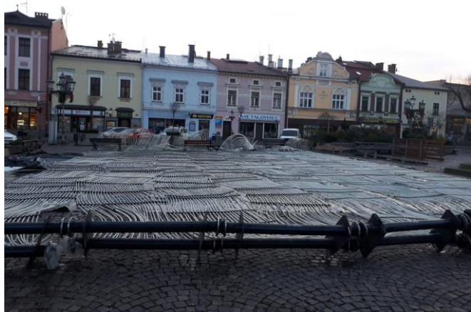
Rury z czynnikiem chłodzącym ułożono na samym dole instalacji
