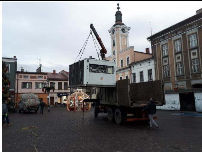
Sercem instalacji chłodzącej lodowisko jest agregat chłodniczy
