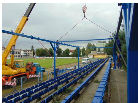
Budowa zadaszenia trybun na Stadionie Miejskim w Skoczowie
