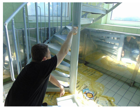
Konserwacja schodów na zjeżdżalni wodnej
