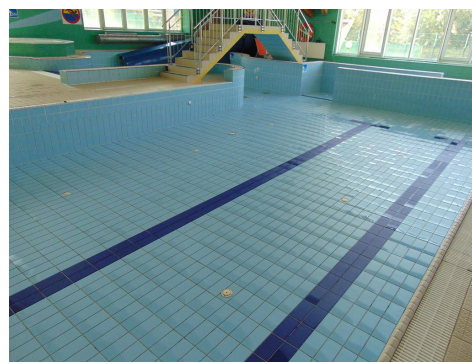
Wyczyszczona niecka basenu rekreacyjnego
