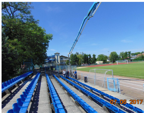
Zalanie fundamentów pod zadaszenie trybun na Stadionie Miejskim
